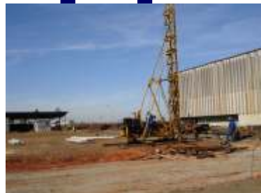
Início dos trabalhos da ampliação
